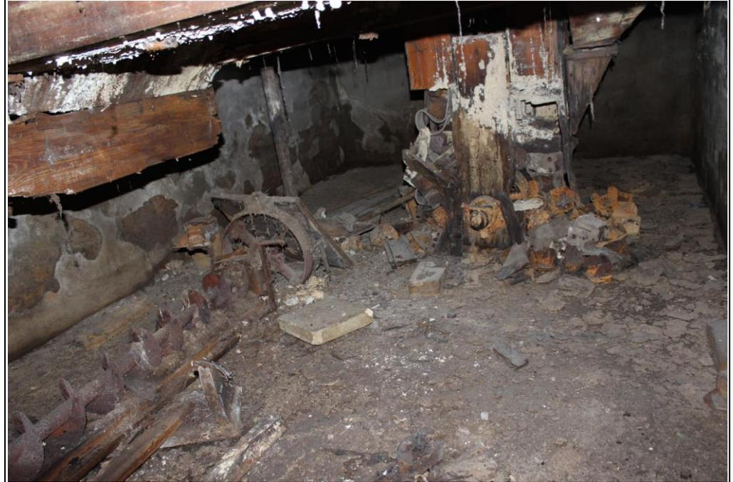
**Innenansichten - Mahlboden/Elevatorkeller:** Sackaufzugsklappen; Elevatorkeller mit Förderschnecke und Elevatorfuß Annahmeelevator
