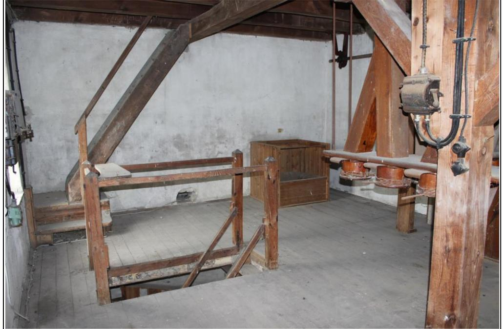
**Innenansichten - Behälterboden:** Treppen vom Mahlboden und zum Sichterboden; Detail Schüttgasse zur Beschickung des Schrotgangs, Sackbank
