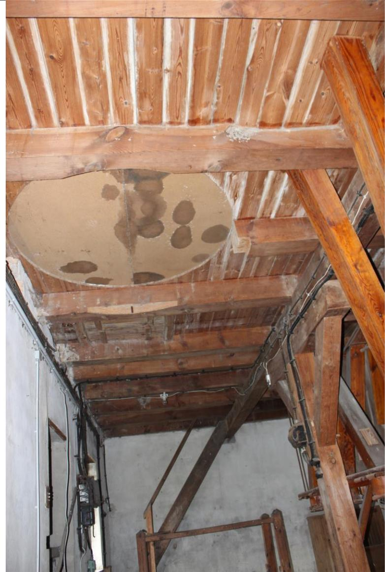
**Innenansichten - Behälterboden:** Druckfilter zum Abscheiden der Schälkleie (Schälmaschine); Standort der ehemaligen stehenden Mischmaschine
